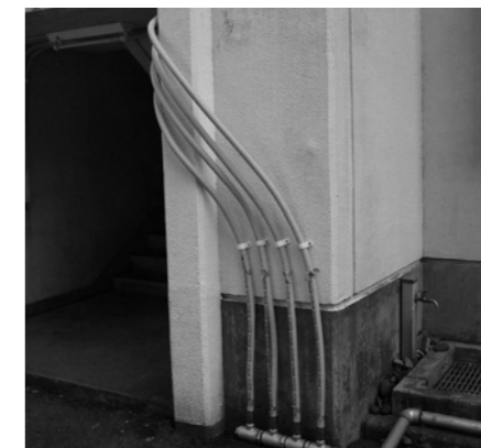
▲(内管修繕仮設配管) 灯外内管 ヘッダー方式によるPSフレキ接続(アパート)
