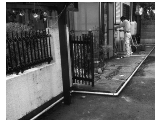
▲(応急仮設配管) 私道共用管 白管転がし(戸建住宅)
