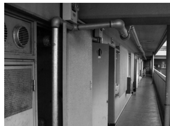
▲(内管修繕仮設配管) 灯外内管共用部 露出白管によるPS接続配管(アパート)
