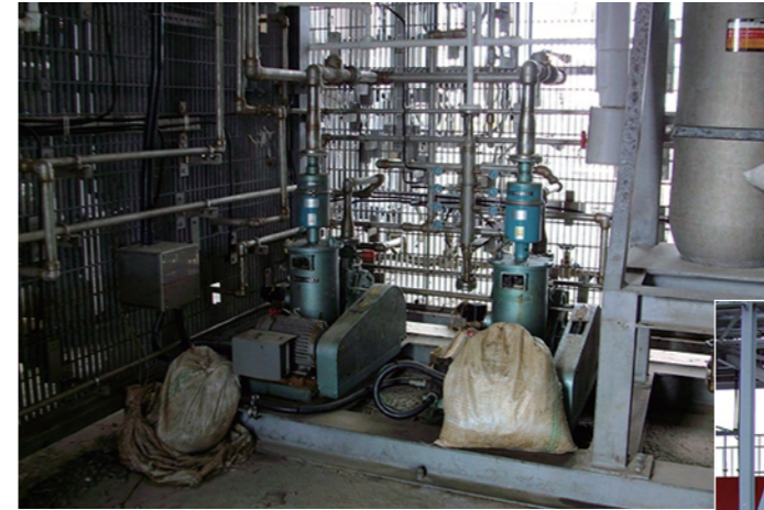
◀▼サンプリング設備ではサンプリングポンプ等の機器が水没。建屋周辺の土砂の一部が流出した。
