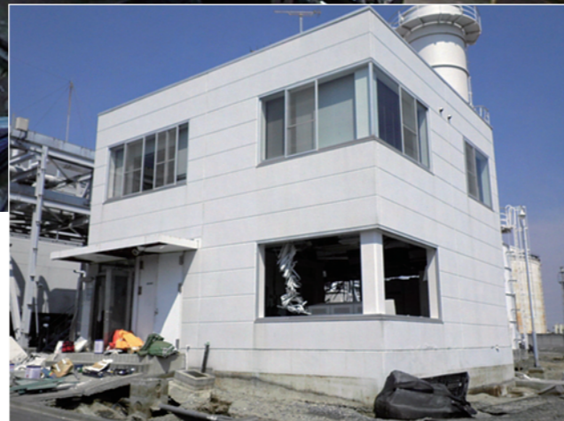
▲▶ LNG 船入船時の監視棟であるバスセンターは1階部分が完全に水没し、大破。計装機器や制御装置が損壊した。また、蒸気配管や計装空気配管が変形した。
