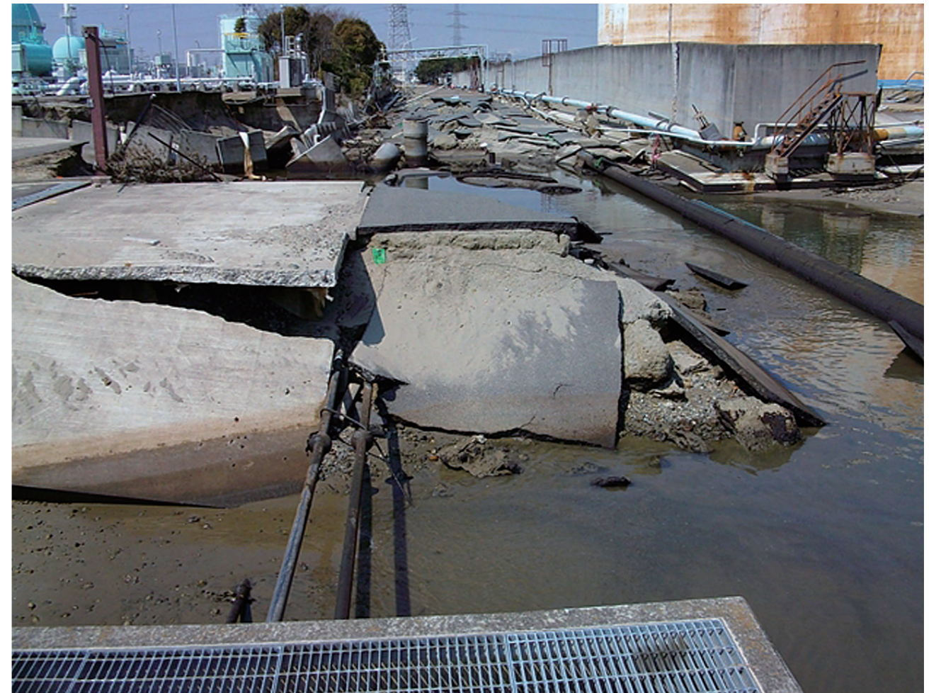
▼海水取水設備は取水路周辺や取水路上部の地盤等が喪失し、排水路周りの護岸が損壊した。写真は「海水取水路（カルバート）」であるが、上部が崩落している。また、オープンラック式ペーパライザー（ORV）用の海水取水路には土砂が堆積し、取水不能となった。
