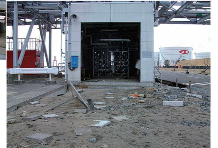
◀▼サンプリング設備ではサンプリングポンプ等の機器が水没。建屋周辺の土砂の一部が流出した。
