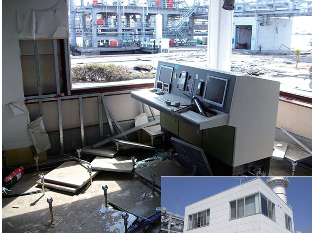
▲▶ LNG 船入船時の監視棟であるバスセンターは1階部分が完全に水没し、大破。計装機器や制御装置が損壊した。また、蒸気配管や計装空気配管が変形した。
