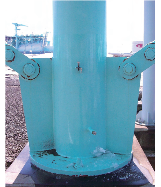
▲球形ガスホルダーは支柱アンカーボルトの伸び（最大 10mm 程度）のほか、支柱タイロッドブレードの伸びやズレが多数発生した。
