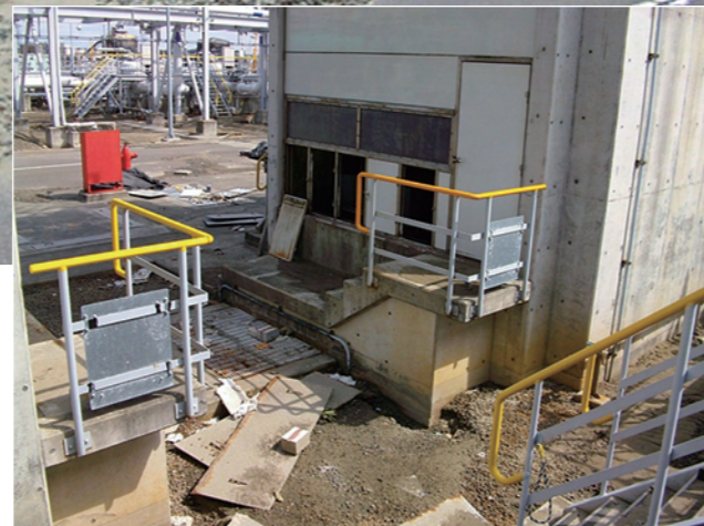
▲▶ ORVはフロア1階部分が水没。パネル内へ海生物や海砂が侵入、パネル扉が破損した。
