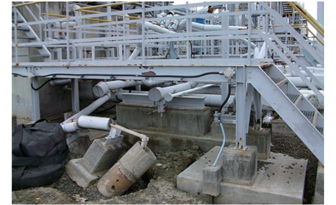
◀再冷水設備では凍結防止用蒸気配管が大破。再冷却塔の基礎地盤が流出し、ポンプ架台の基礎地盤が露出した。
