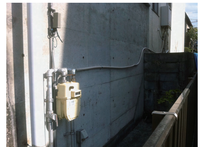
▲フレキシブル管による仮設配管の取付。
