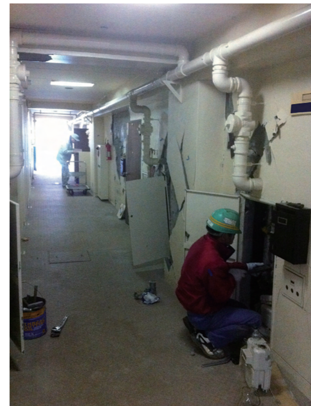
▲集合住宅での工事。
