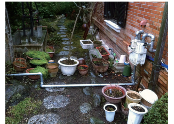
▲白管による仮設配管の取付。
