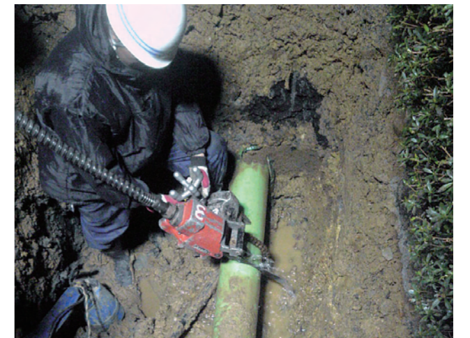
▲本管切断工事。
