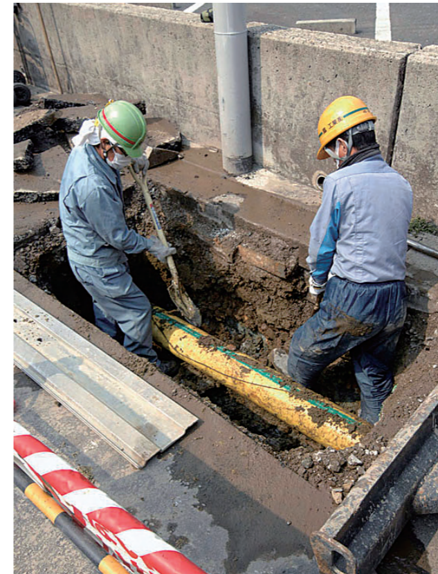
▲本管切断前の掘削工事。
